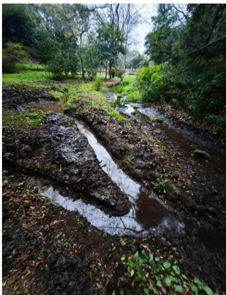
拡充された水路
